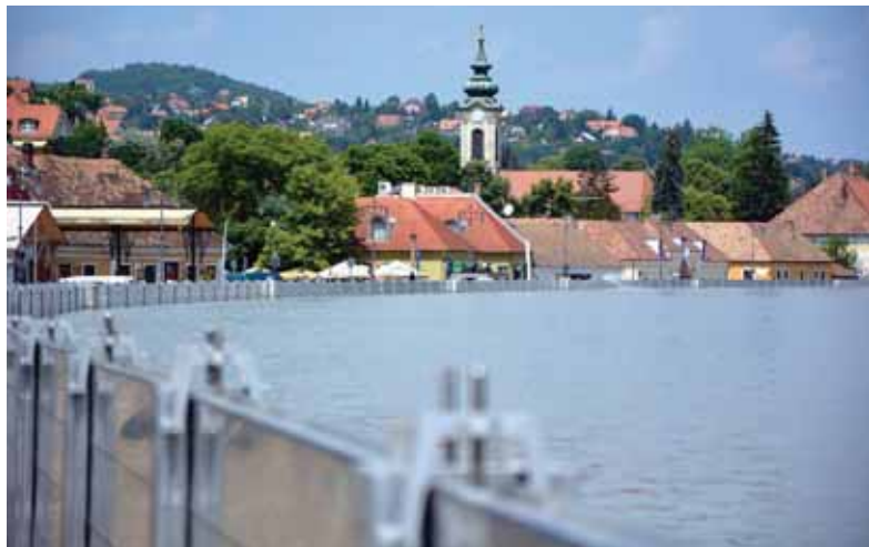
A szentendrei mobil árvízvédelmi fal sikerrel vizsgázott a 2013-as dunai árvíz idején
