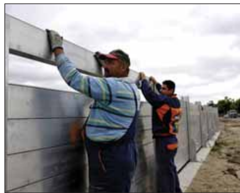
A könnyűfém ötvözetből készült mobilfal elemei kézi erővel is gyorsan összeállíthatók
