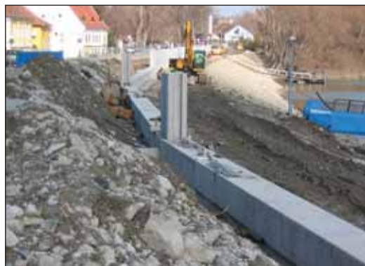
Komoly földmunkákkal jár az árvízvédelmi mobilfal alapozása
