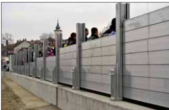
Mélyen a talajba süllyesztett fix vasbeton fal, a felszínen mobil oszlopok és betétgerendák – így épül fel a mobil árvízvédelmi fal
