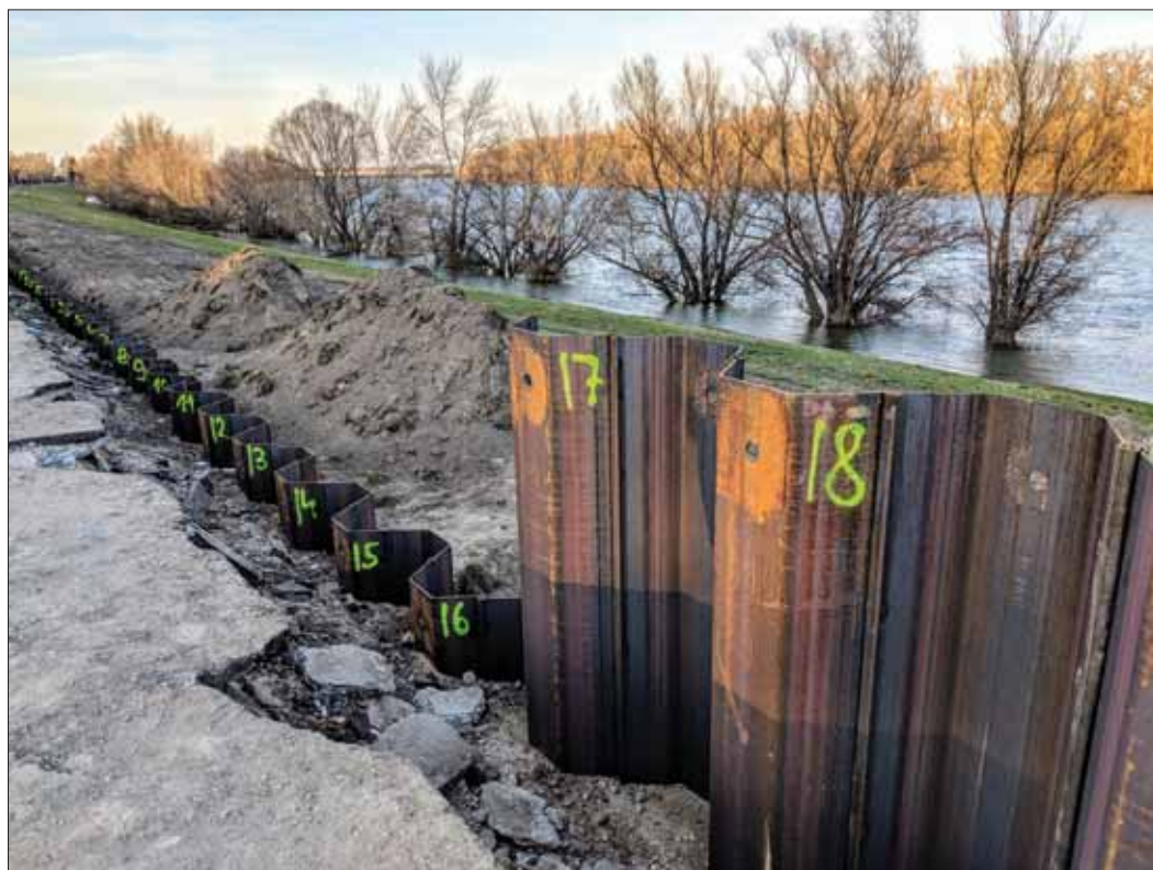
A szádlemezek egy része már a talajba került, de felső élük még kiemelkedik a földből. A munkaterületen tartózkodni balesetveszélyes és tilos!
