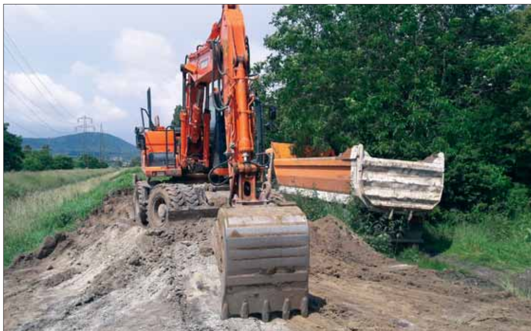
Földmunkákkal kezdik a szivárgáscsökkentő fal építésének előkészítését
